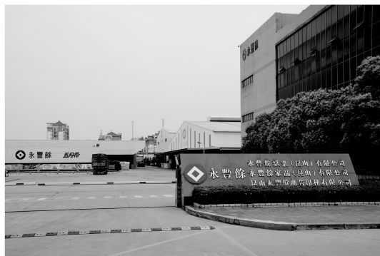
图 3-23 永丰余家品(昆山)有限公司厂景图
